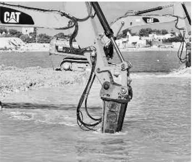
Der Hydraulikhammer HP 5000 auf einem Cat 325 D und ein HP 7000 auf einem Cat 330 D helfen beim Unterwasserabbbruch. Fotos: Indeco
